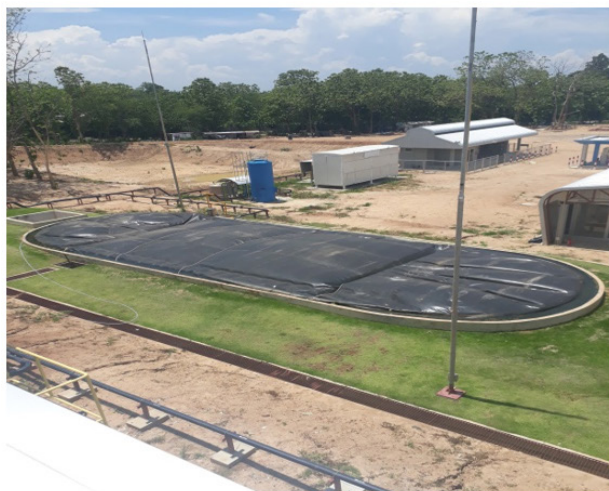
รูปพลาสติกเก็บไบโอแก๊สบ่อหมักราง
