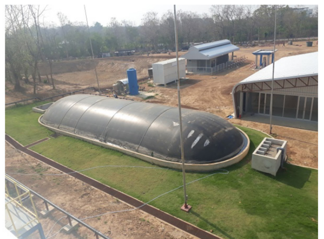
รูปพลาสติกเก็บไบโอแก๊สบ่อหมักราง
