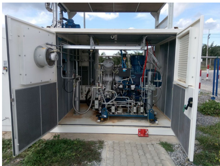
เครื่องอัดก๊าซไบโอมีเทนอัด (CBG Compressor) ณ ศูนย์ถ่ายทอดเทคโนโลยีและต้นแบบระบบผลิตก๊าซไบโอมีเทนอัด (CBG) มหาวิทยาลัยเชียงใหม่ จ.ประจวบคีรีขันธ์
